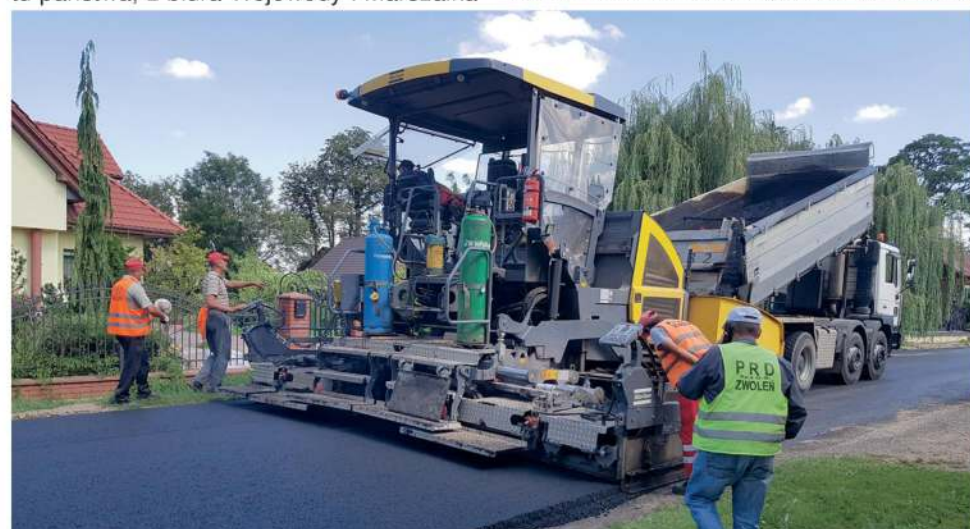
Przebudowa drogi w Długowoli, gm. Lipsko, 2018 r.
