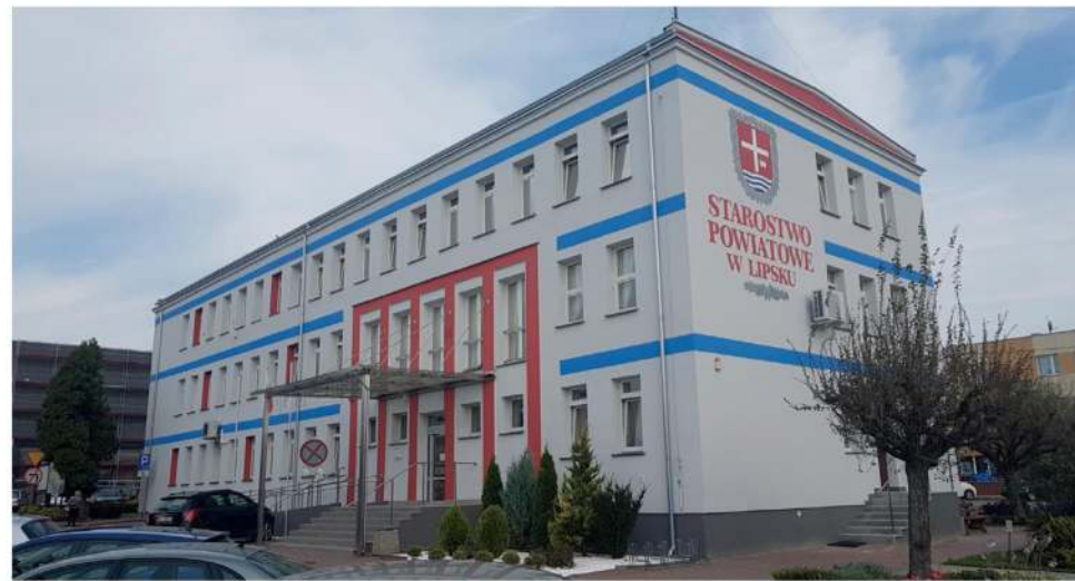
Wyremontowany budynek Starostwa Powiatowego w Lipsku, 2018 r.
