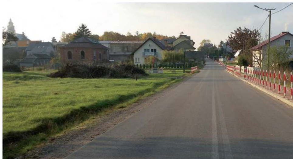
Przebudowana droga powiatowa Ciepiałów-Rekówka z chodnikiem i elementami bezpieczeństwa ruchu drogowego w 2015 r.
